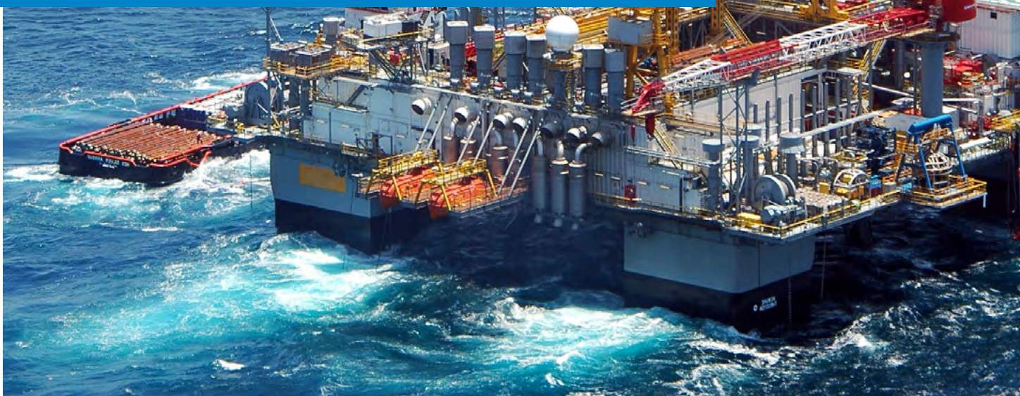
Plataforma para aguas profundas, Golfo de México
