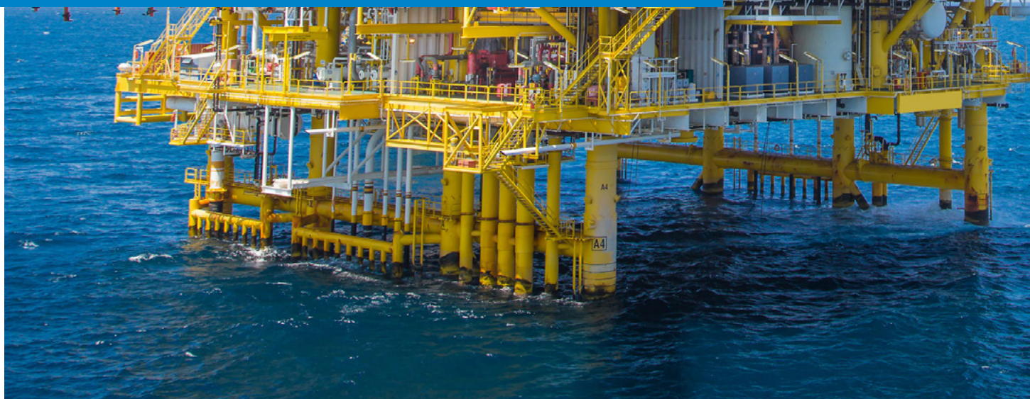
Plataforma de compresión, Centro de Proceso costa afuera, Golfo de México
